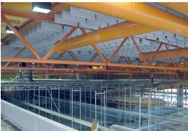
Absorber Plano S pieza de aluminio con ganchos, se instalan colgados a un cable de acero sujeto a los extremos.
